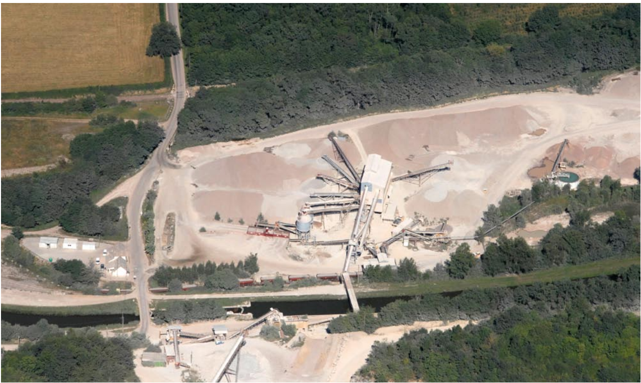
SARY-LES-EPIRY : DÉTAIL DES INSTALLATIONS
