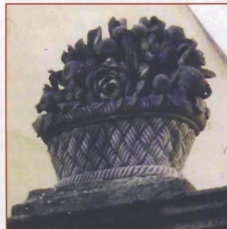
Moulure récemment piquetée et refaite en ciment dans la rue de l'Arquebuse.
