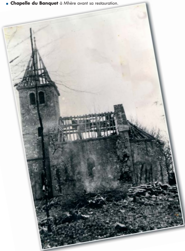
■ Chapelle du Banquet à Mhère avant sa restauration.
