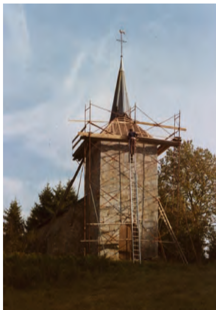
▲ Restauration de la toiture du clocher
