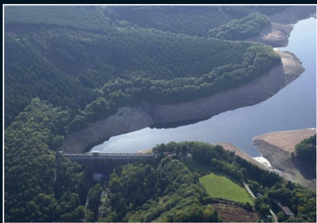
Lac du Crescent - Le barrage et l'usine
