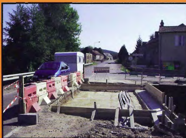
Pont de Barnay (71) lors des travaux ▲
