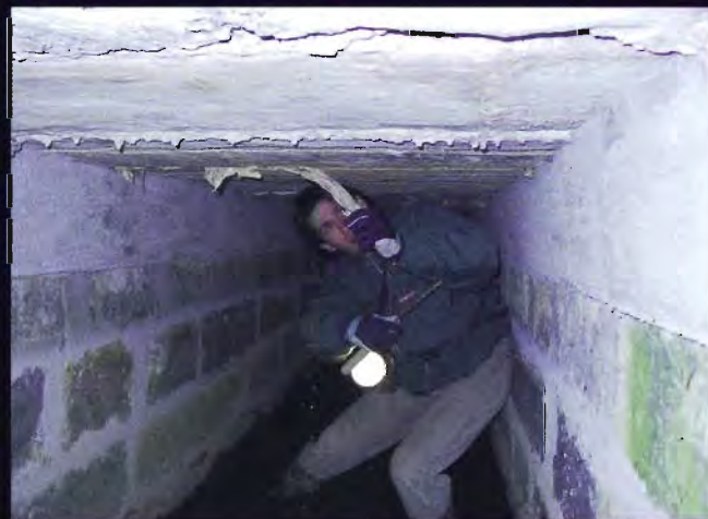
Nettoyage du site après réfection de l'ouvrage afin de le rendre accessible aux chauves-souris ▲
