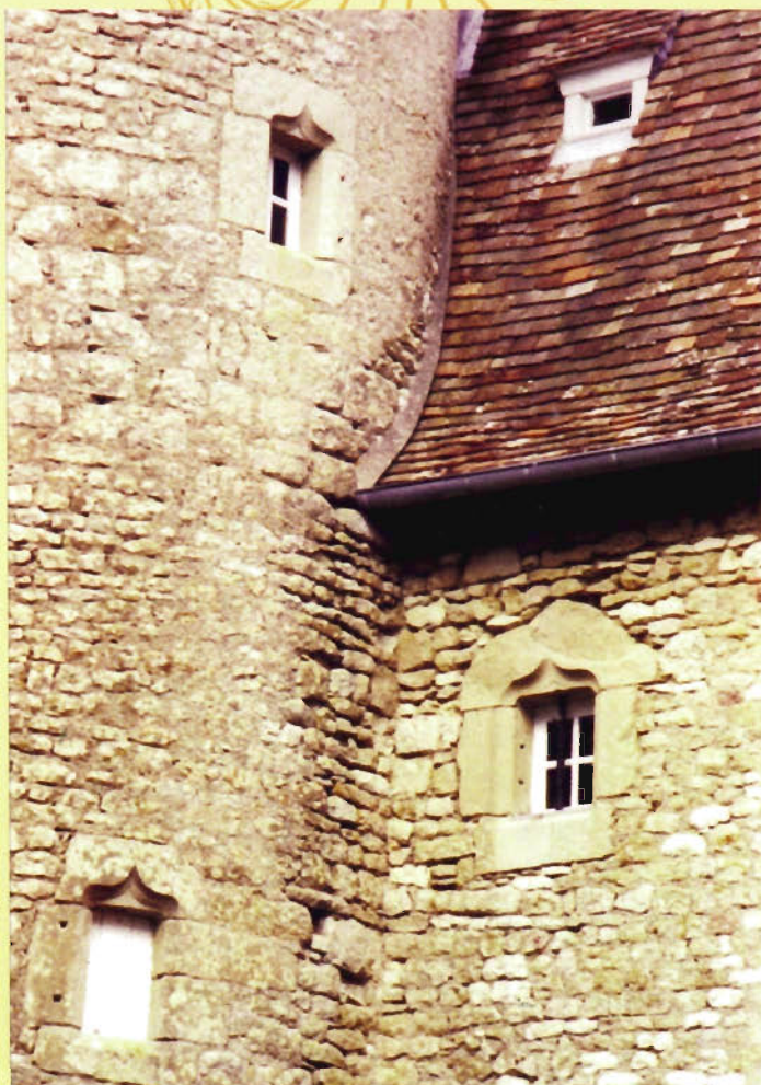
Les lucarnes du toit du prieuré (XIV e siècle) ont été ouvertes au XX e siècle Ouvertures de la tour et du corps de bâtiment avec accolades ▼
