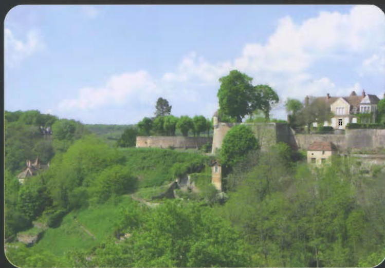
Bastion de la petite porte depuis les Chaumes
