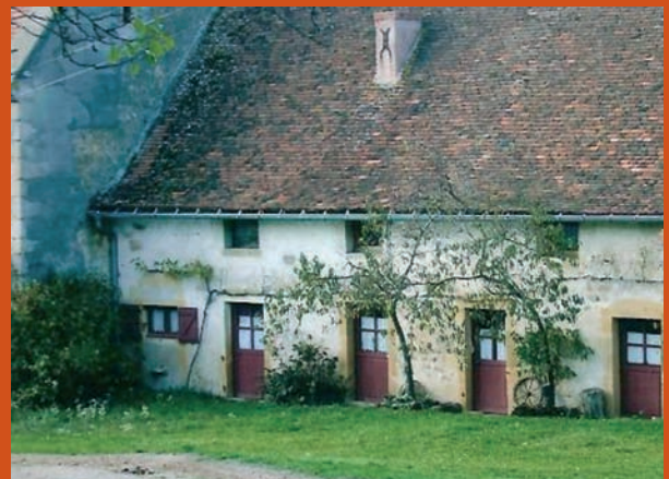
■ Les Payots. Maison des parsonniers accolée à celle du maître de la communauté
