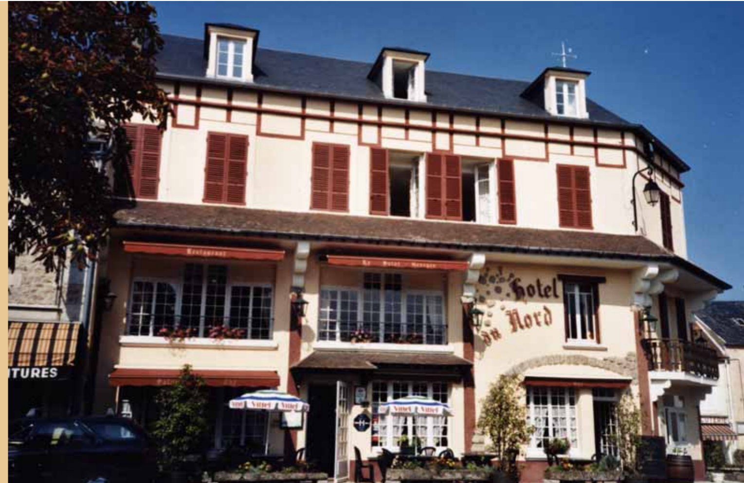
▲ Façade rénovée de l'hôtel
