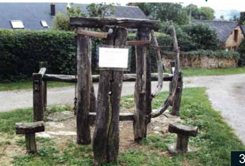
Travail du Mont quelques années après sa restauration
