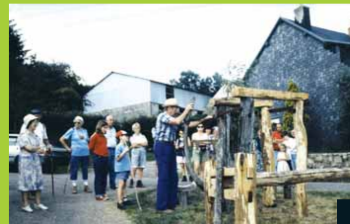
▼ Démonstration de l'utilisation du travail du Mont après sa restauration. Les bois clairs montrent les bois changés. Cette restauration a été faite en respectant l'état original.
