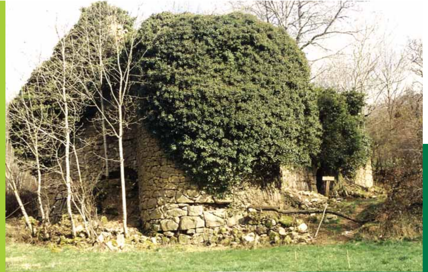
▲ Vue de la tour sud-ouest de la maison seigneuriale : la hauteur de cette tour est conservée. Sur la partie gauche, les conduits des cheminées sont plus élevés. Façade sud à droite. Il existait une tour symétrique à celle-ci proche du chemin d'accès, elle a été complètement démantelée. Remarquez la qualité de la construction, dans l'assemblage des blocs de granite.
