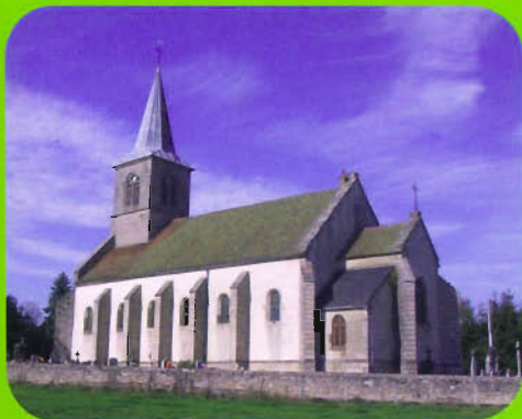
Au XI e siècle, la paroisse de Saint-Léger-de-Fourches faisait partie du diocèse d'Autun. A l'église en ruine (qui ne se situe d'ailleurs pas sur le même site), on a substitué, en 1860, une jolie construction d'après les plans de N. Fénéon, architecte à Dijon. De style roman à trois nefs, elle comporte dix-huit contreforts. Le campanile se fait remarquer par l'élégance de sa hauteur de trente-trois mètres cinquante. Photo de M. René Ribes (Saint-Léger-de-Fourches).
