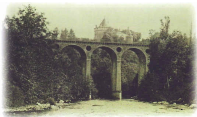
Le site de Chastellux après la construction du pont actuel. ▲
